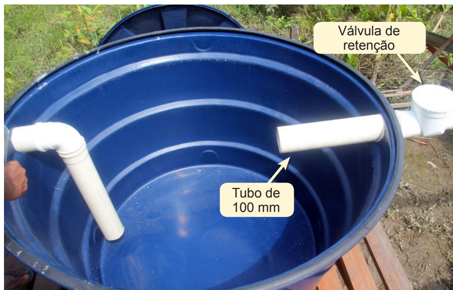
Figura 8. Encaixe do tubo de 100 mm no furo superior da primeira caixa, com a válvula de retenção antes da entrada na primeira caixa, e saída para a segunda caixa.
