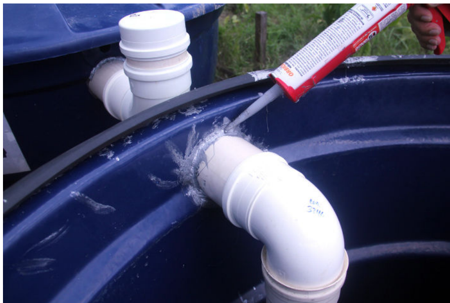
Figura 16. Uso do selante de poliuretano na parte interna das caixas do sistema para fixar melhor os tubos.
