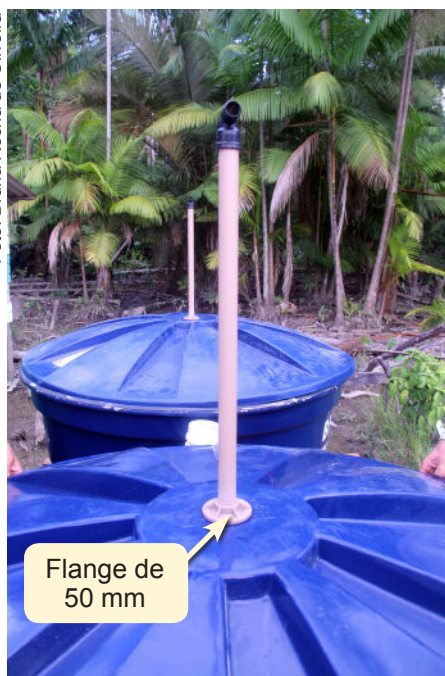
Figura 14. Tampa da caixa com o flange e o tubo de 25 mm colocado ao centro.
