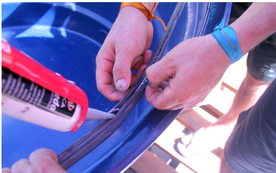
Figura 4. Borracha utilizada na vedação do sistema de fossa séptica biodigestora.
