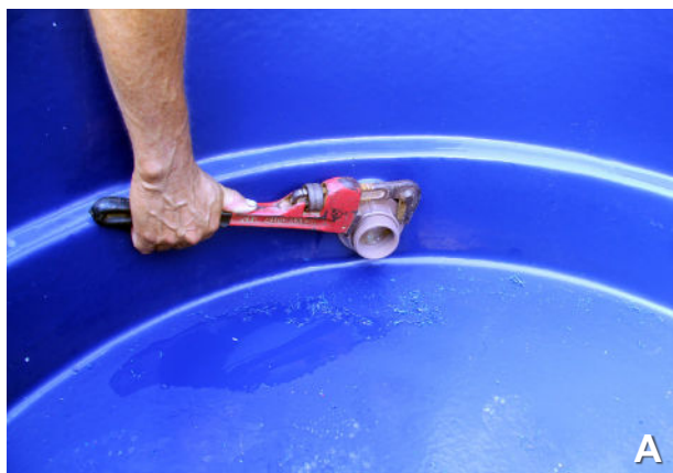
Figura 13. Colocação do flange de 50 mm na última caixa, por onde sairá o efluente tratado, usando uma chave de tubo (A). Sistema para controle da saída do efluente da última caixa, com a mangueira de alívio de gases (B).
