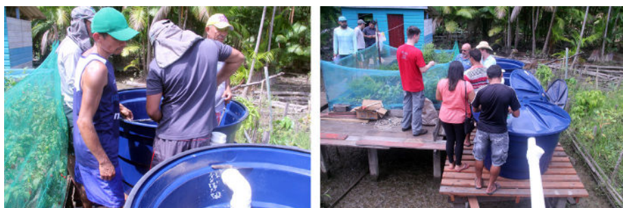
Figura 22. Oficina prática na Ilha das Cinzas, quando monitores locais montaram uma fossa biodigestora para validação da cartilha e demonstração da tecnologia para técnicos e moradores de ilhas vizinhas.
