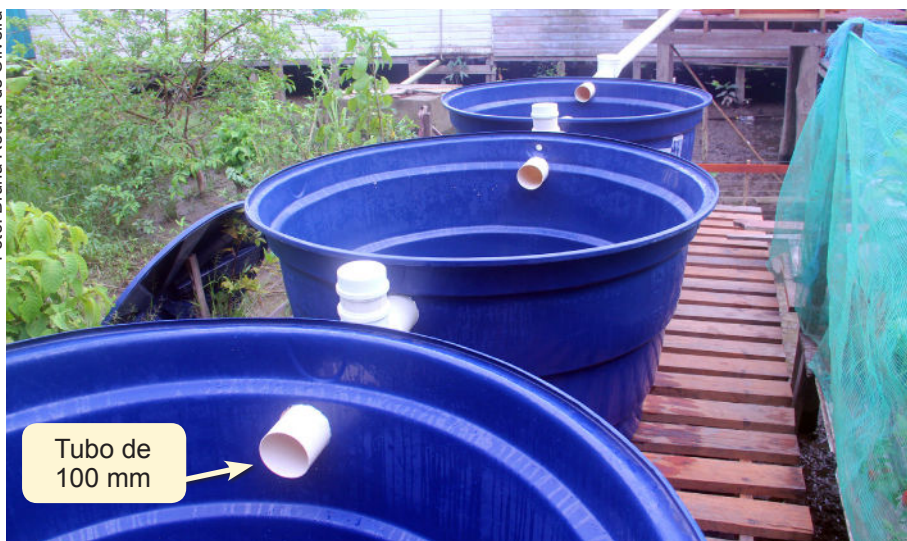
Figura 12. Interligação das caixas por meio dos tubos.
