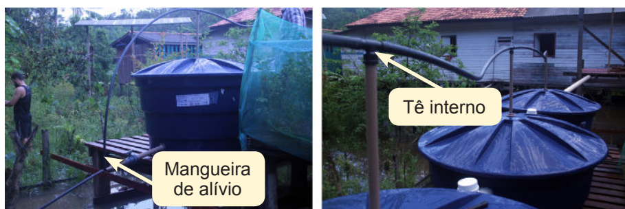
Figura 19. Sistema da fossa séptica biodigestora montado, mostrando a mangueira de alívio dos gases e sua interligação com o tubo de saída do efluente.
