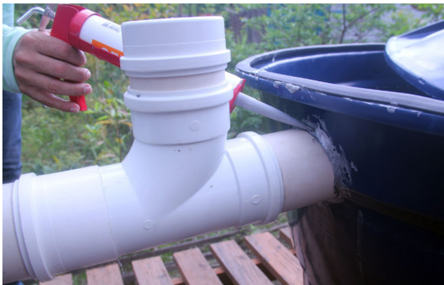
Figura 18. Uso do selante de poliuretano para vedação dos tubos nas caixas.
