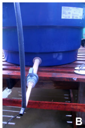
Figura 13. Colocação do flange de 50 mm na última caixa, por onde sairá o efluente tratado, usando uma chave de tubo (A). Sistema para controle da saída do efluente da última caixa, com a mangueira de alívio de gases (B).
