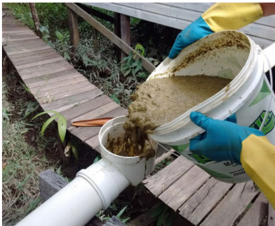
Figura 21. Adição da mistura do esterco e água pela válvula de retenção para ajudar no processo de decomposição dos dejetos humanos.
