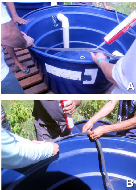
Figura 15. Borracha de porta de Kombi utilizada na vedação das caixas (A) e aplicação do selante para colar a borracha na borda da caixa (B).
