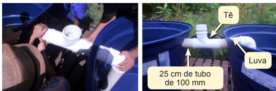
Figura 10. Conexão entre a primeira e a segunda caixa, usando dois pedaços de 25 cm do tubo de 100 mm, uma luva e um “Tê” de 100 mm.
