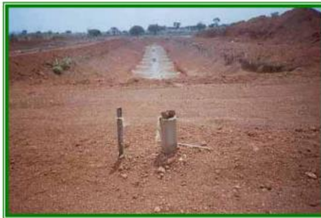
Figura 33 - Vala do Aterro Sanitário de Porto Nacional
