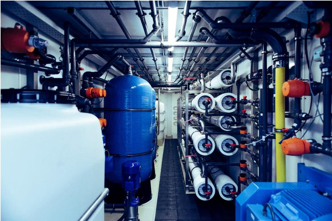
*Figura 2: Interior de uma máquina de tratamento de osmose reversa.*
